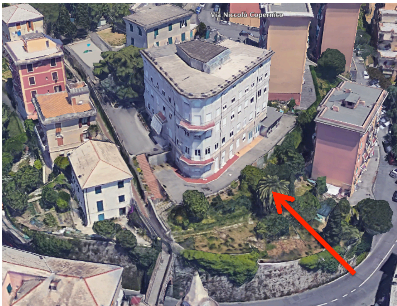
Immobilе sito in Via del Sole civ.9 – VISTA DALL'ALTO LATO SUD
