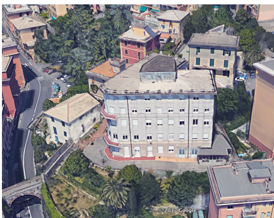
VISTA DALL'ALTO LATO EST
